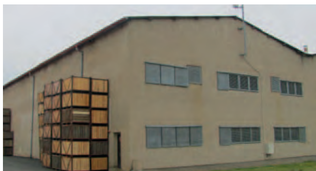
Budova bramborárny v Petrovčích
